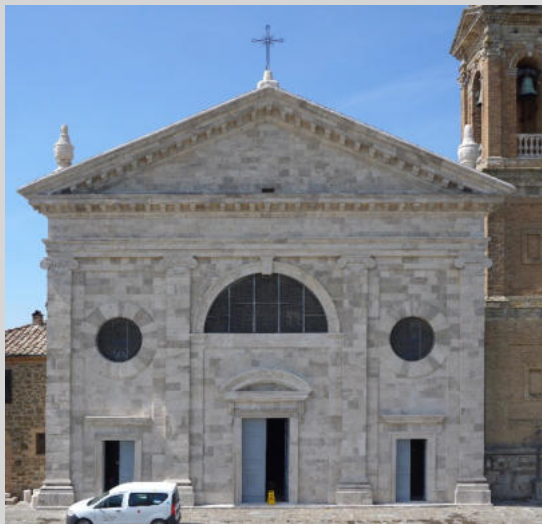
Montalcino, Chiesa della Madonna del Soccorso Restauro della facciata in travertino
